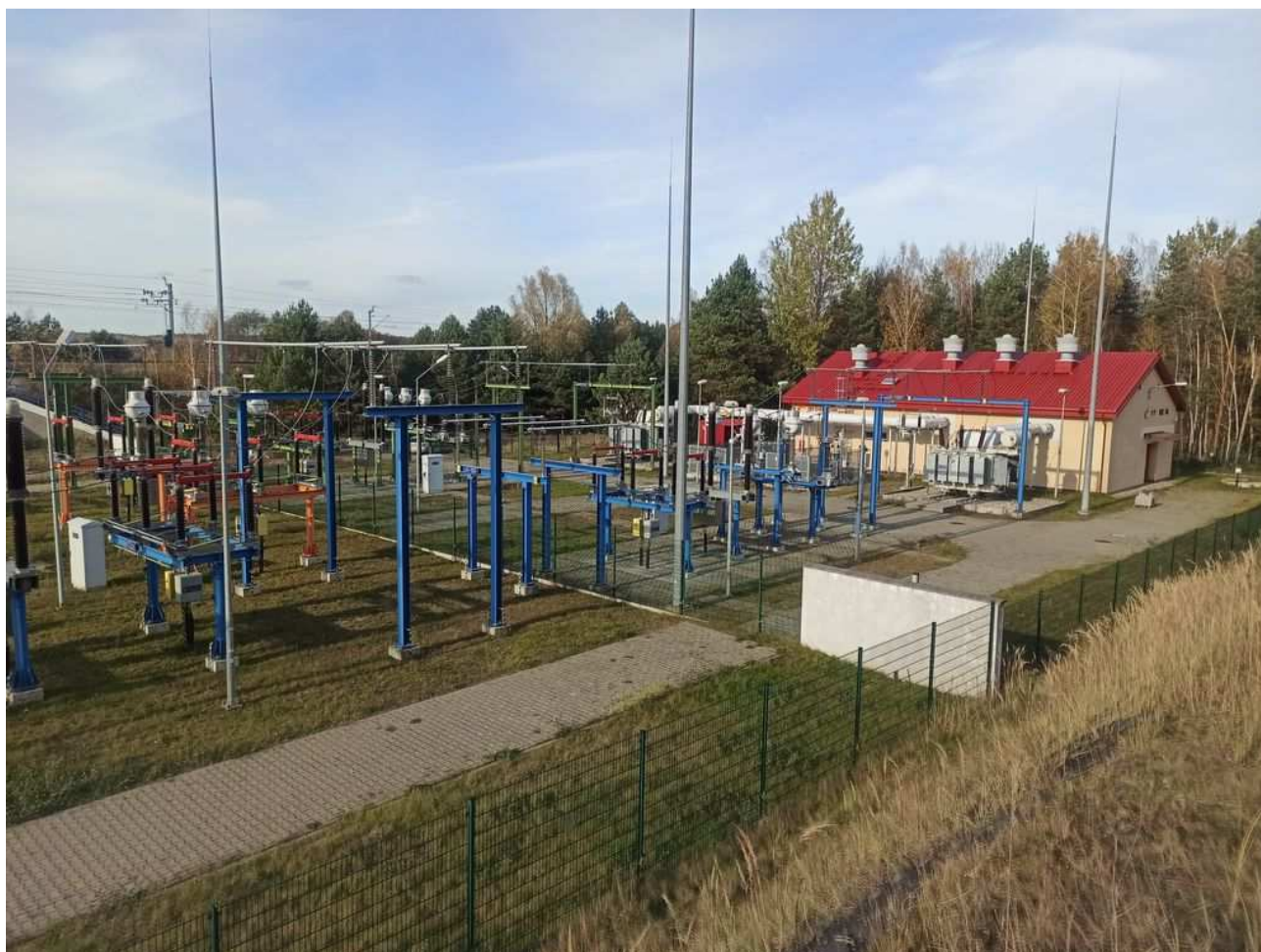
Zdjęcie 1 Badany obiekt
